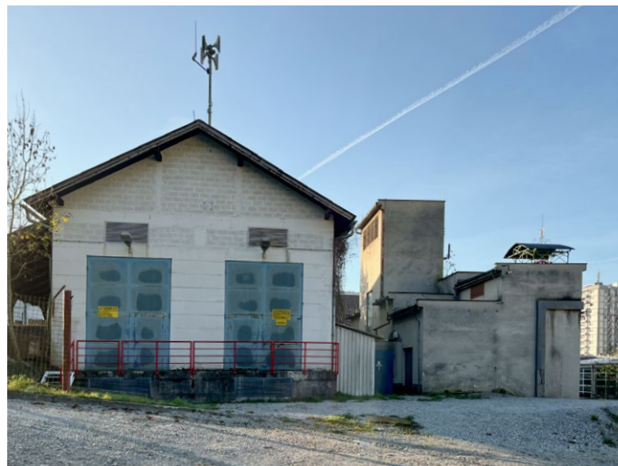
Nova in stara transformatorska postaja
