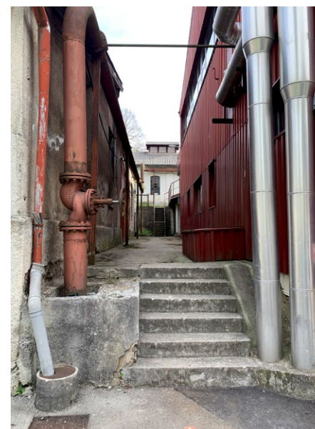
Prostor med strojnico in stavbo Petrola
