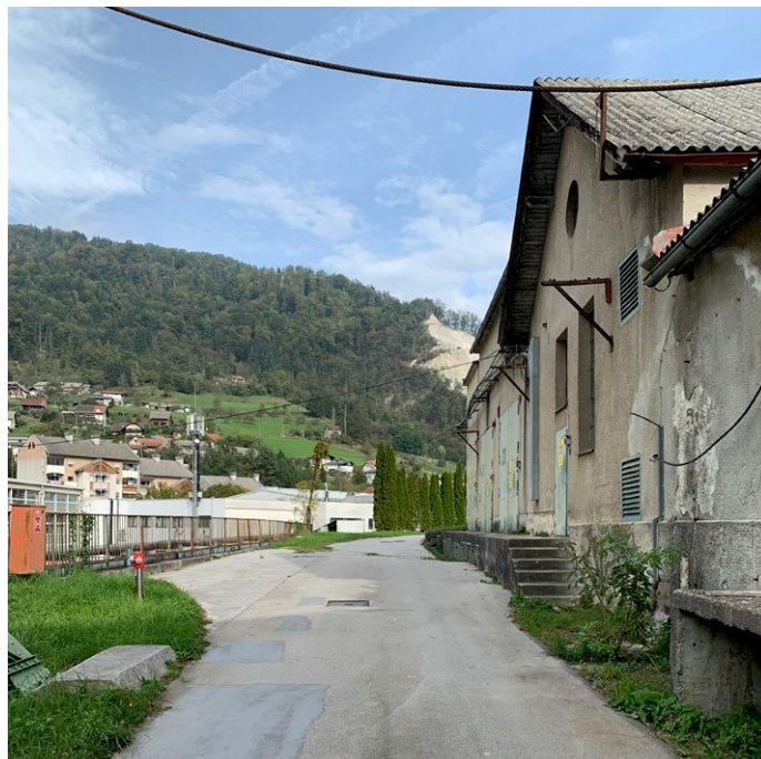
Prostor pred staro transformatorsko napravo
