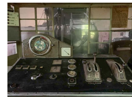
Kontrolna kabina strojnice
