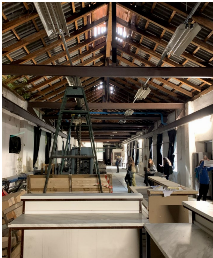
Notranjost kompresorske postaje
