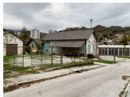
Pogled proti kompresorski in novi transformatorski postaji
