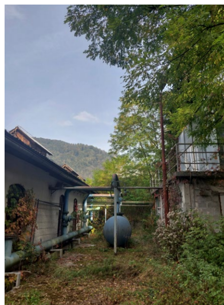
Pogled na območje za kompresorsko postajo
