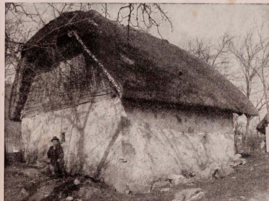
Slika 51. Belokranjska zidanica nad Semičem. Značilna je pletena stena na čelni strani podstrešja. Tehnika pletenja se pojavi na začetni razvojni stopnji hiše že pred tesarstvom in zidarstvom.
