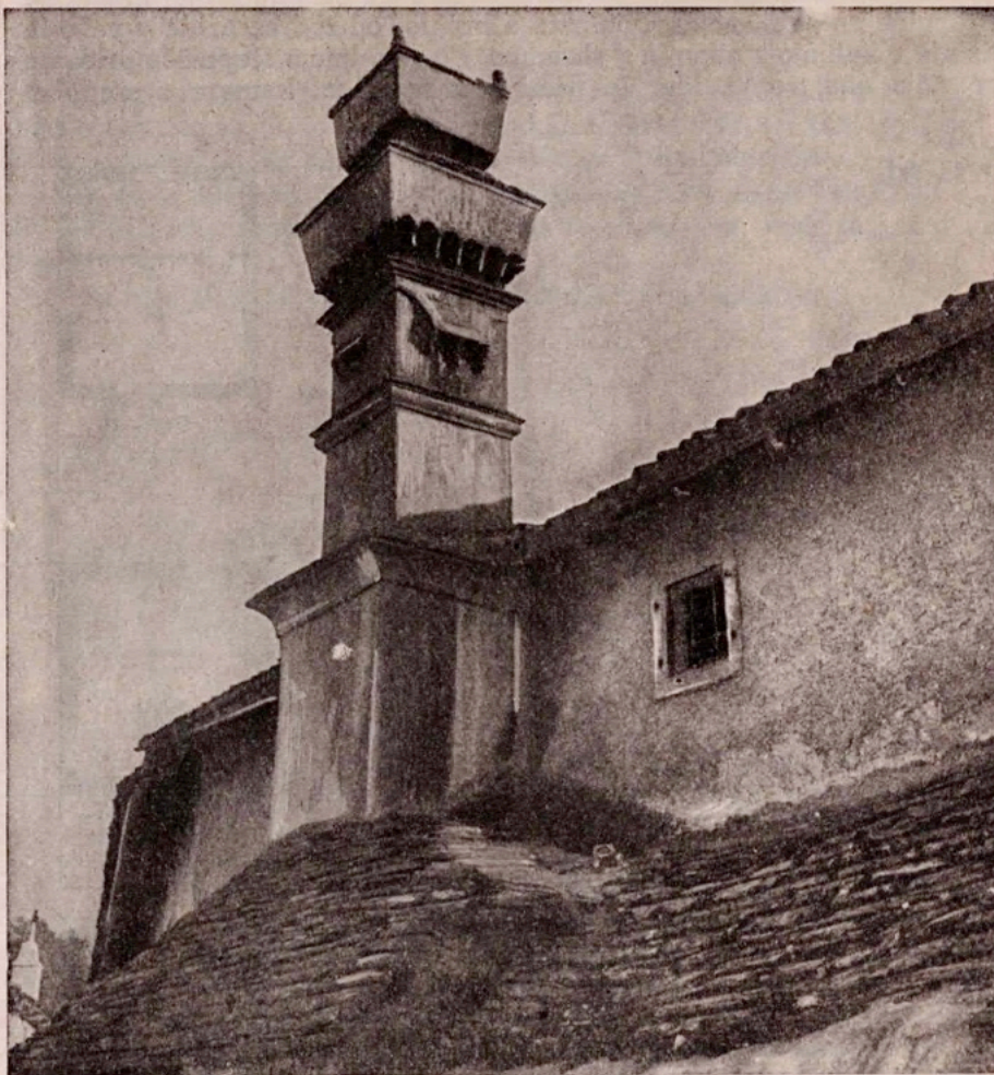
Slika 92. Pri kaminskem tipu primorske hiše je kamin, dimnik, važen sestavni del hišnega ustroja. Kot poudarjen arhitekturni plastični element je lepo oblikovan v zasnovi in členitvi.
