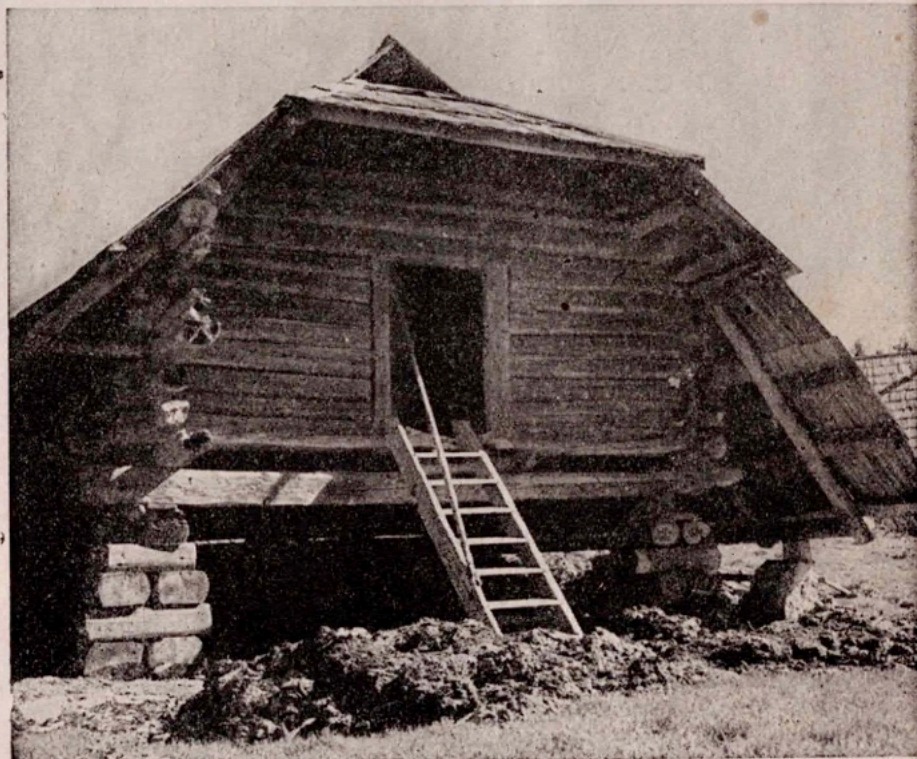
Slika 95. Vhod v prvotne domove na prvi razvojni stopnji je bil dvignjen od tal, tudi ta koliba je zgrajena v prvotni gradbeni tehniki.
