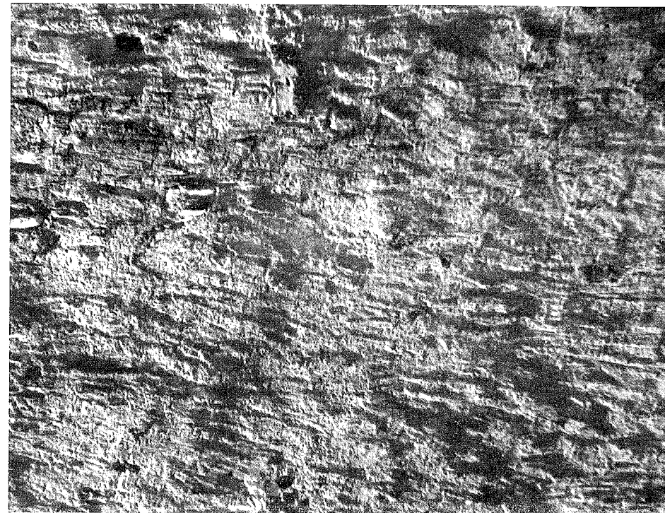
Fasada slovenjegraške cerkve sv. Duha — struktura prvotnega ometa, kakršno si želimo doseči tudi pri novih ometih. — Foto M. Zadnikar
