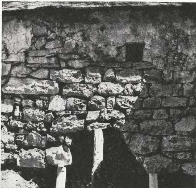
Detajl štanjelske »romanske« hiše pred obnovo notranje stene. — Foto Nace Sumi
