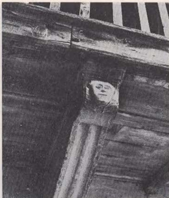
Sl. 10—11 Pliskavica 57: razgibano stopnišče na dvoriščni strani in značilen lesen ganjk; detajl: lesena konzola s kamnito glavo
