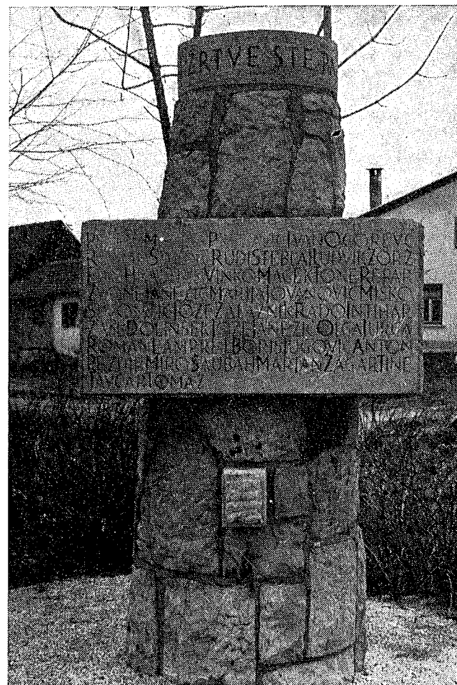
Sl. 7. Ljubljana, Ižanska c. — na kamnu spomenika žrtvam fašizma se že kaže vrsta poškodb, ki jih bo konservator odstranil (f. V. Benedik 1980)
