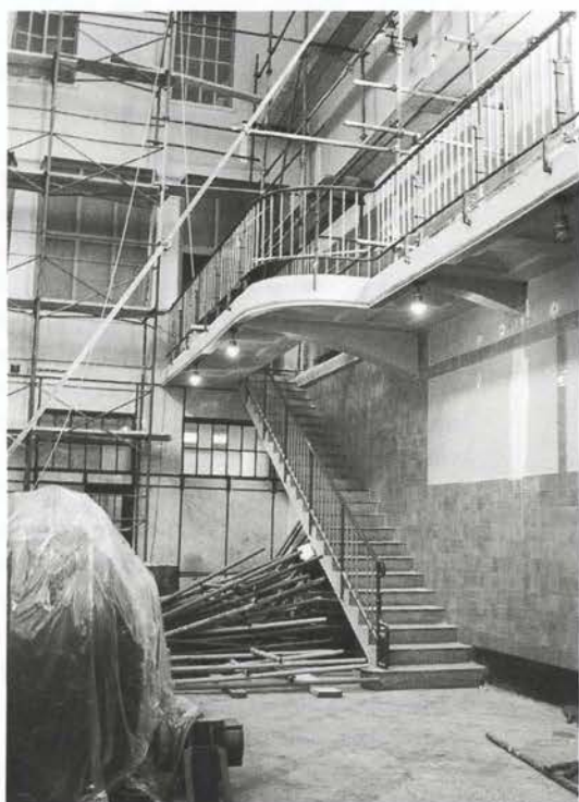
Hidroelektrarna Fala med prenovo
